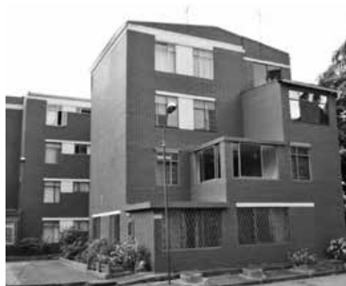
Foto 5 Escalonamiento del módulo
