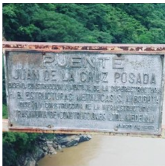
Figura 2. Placa de identificación del Puente Juan de la Cruz Posada. Ituango sobre el río Cauca —destruido—
